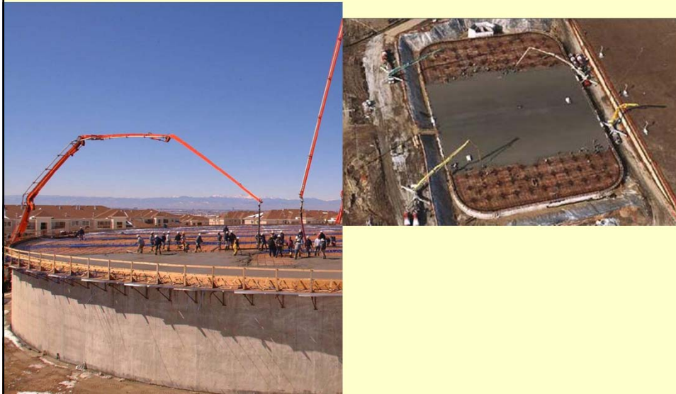
Izvedba prednapete krovne konstrukcije
