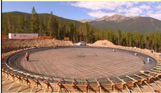
Prednapeta temeljna ploča
