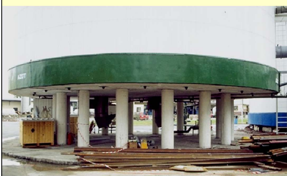
Oštećenje spremnika tekućine nakon potresa u Turskoj (1999)
